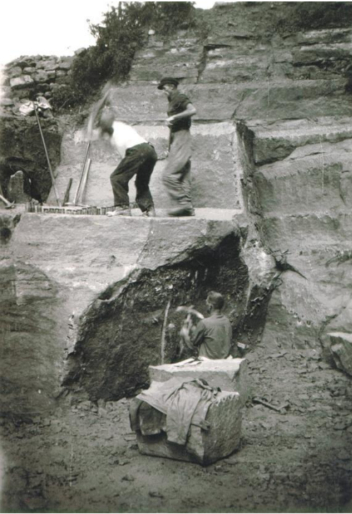
Steinbrucharbeiten für den Bau des Gotteshauses St. Michael Ziegelerden
